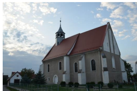
Fot. 14. Osiek Grodkowski. Kościół filialny pw. Wniebowzięcia NMP (fot. materiały Gminy Grodków).
