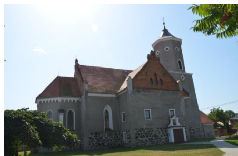
Fot. 19. Więcmierzycy. Kościół filialny pw. św. Bartłomieja (fot. materiały Gminy Grodków).
